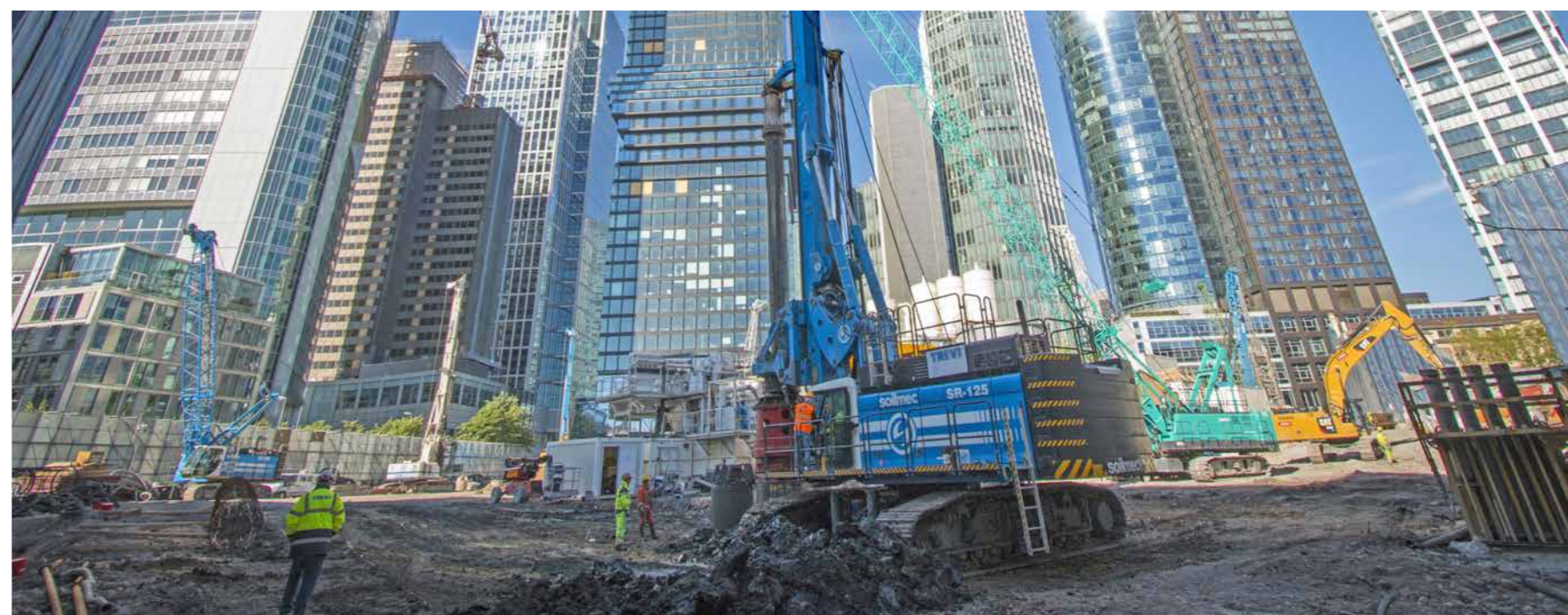
Consolidamenti per il Progetto "4 Frankfurt" - Germania
