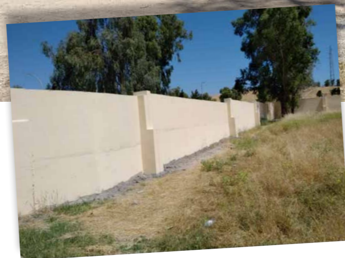
Nuovo muro di cinta della scuola superiore femminile del villaggio di Mosul.
