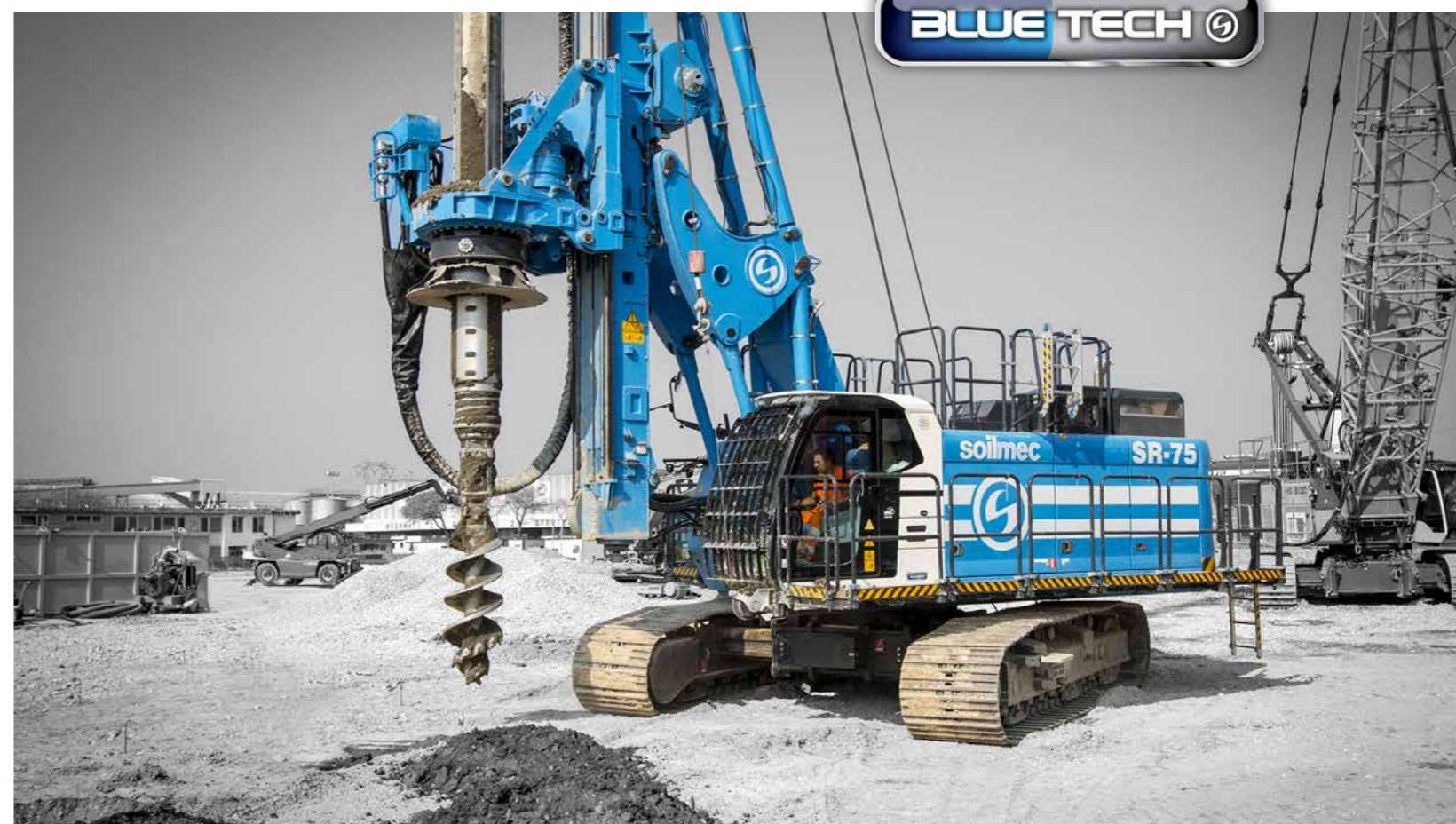
La prima SR-75 Blue Tech Line in cantiere, Ravenna - Italia
