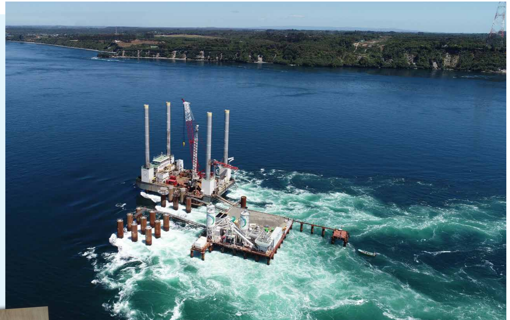
Ponte di Chacao, opere di fondazione per la pila numero 1 - Chile
